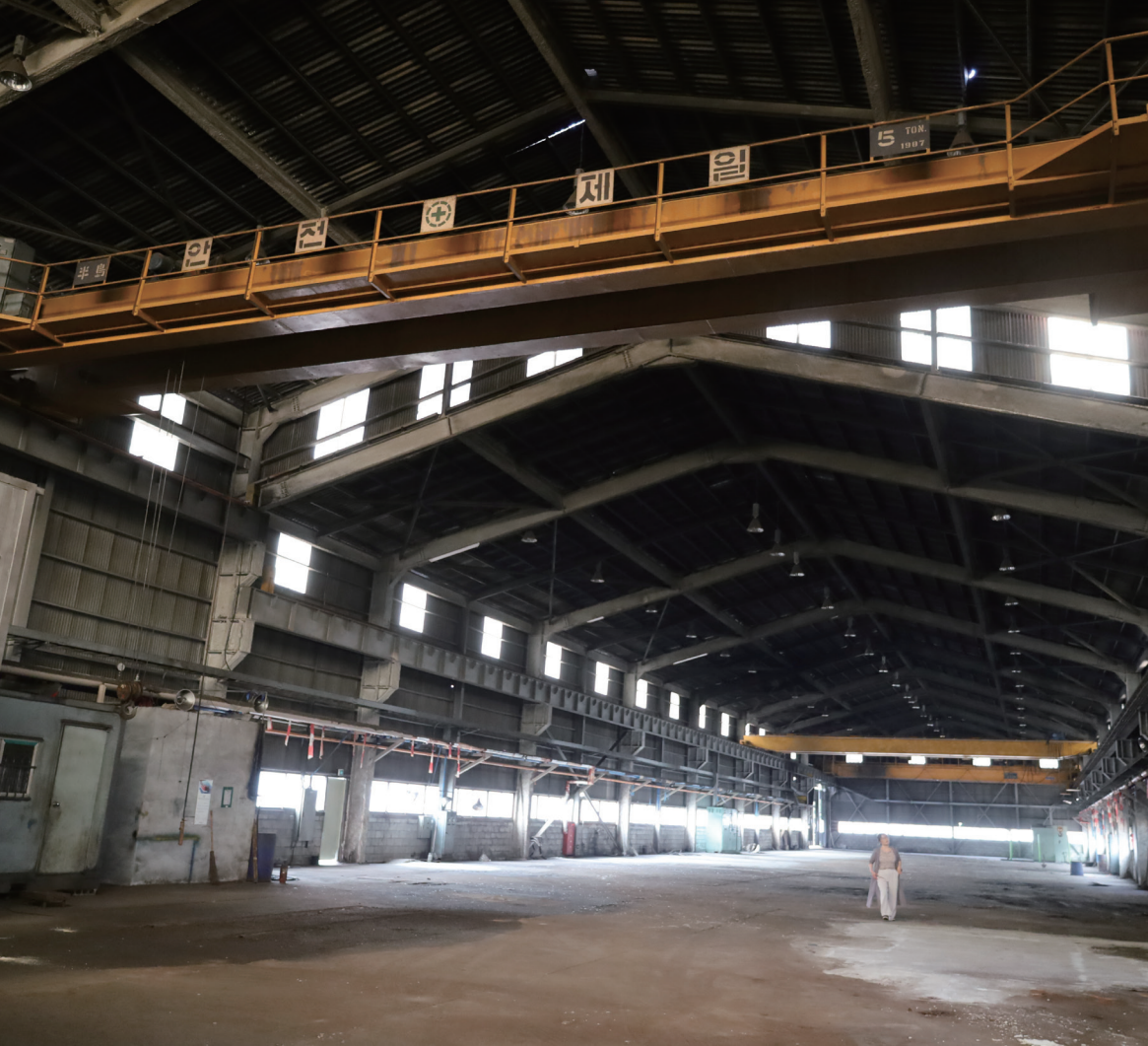
기계 철거 후 공장의 내부
