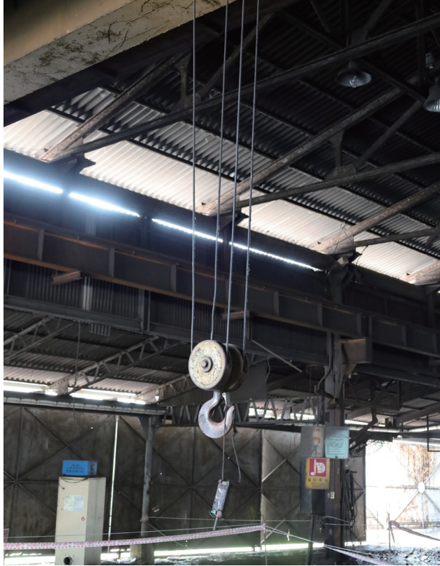
철거 후 공장 풍경
