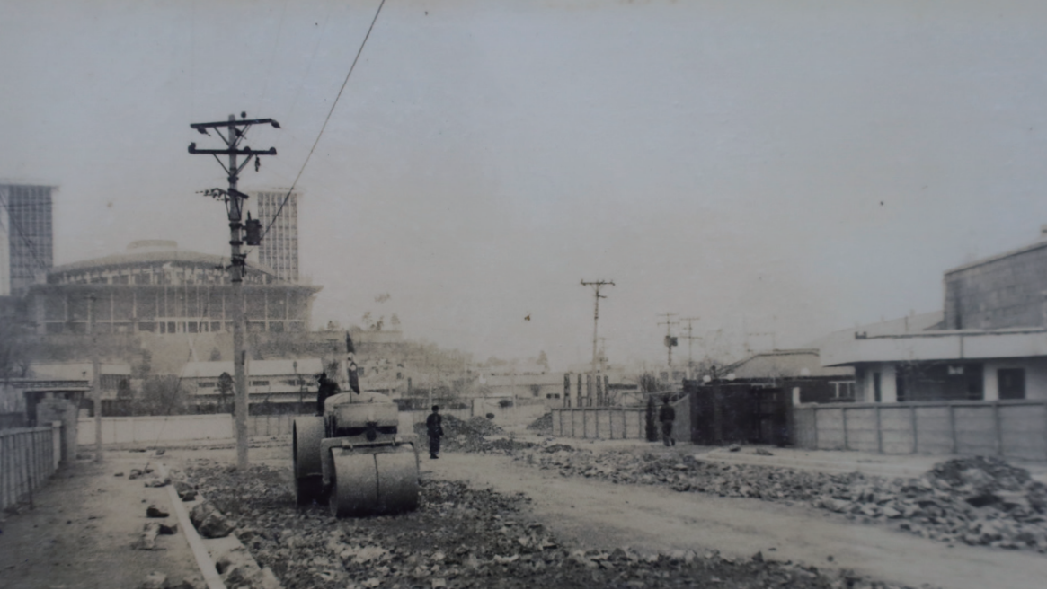
인천기계공단 도로 공사 현장(사진 뒤에 지금은 사라진 선인체육관이 보인다.)
